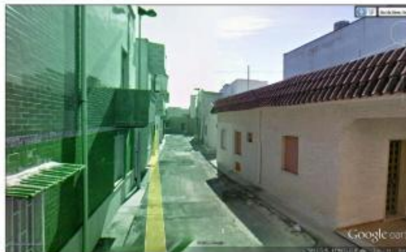
(4) spazi urbani ed edilizia privata da riqualificare
