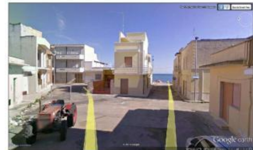
(6) spazi urbani ed edilizia privata da riqualificare
