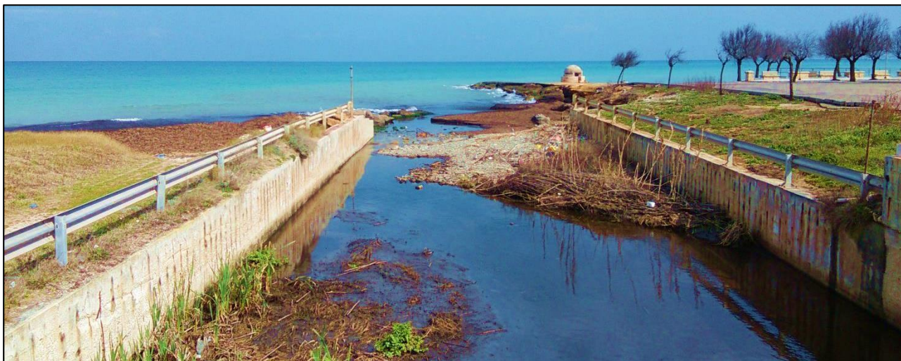
Figura 7 – Sbocco a mare del Canale Infocaciucci; a destra inizia l'ultimo tratto di costa prevalentemente caratterizzato da spiaggia bassa sabbiosa.
