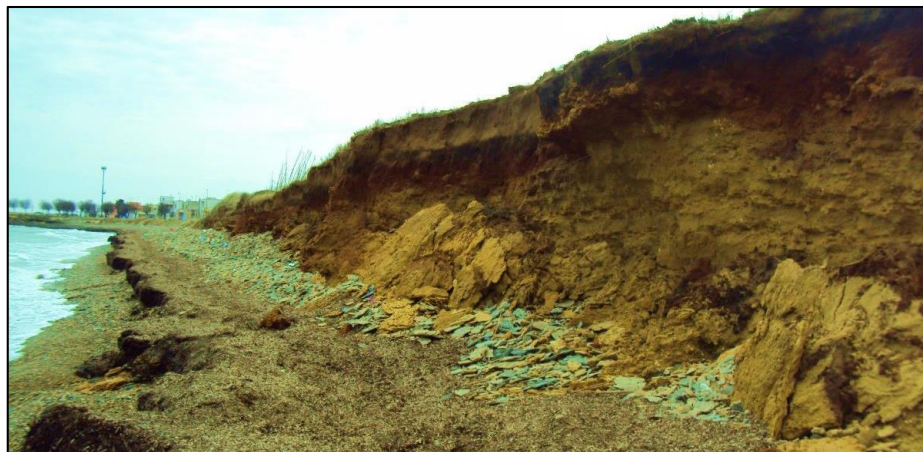
Figura 8 – Evidenze di dissesti recenti nel Comune di Torchiarolo, assenza di una spiaggia al piede della falesia che funge da protezione contro l'azione del moto ondoso.
