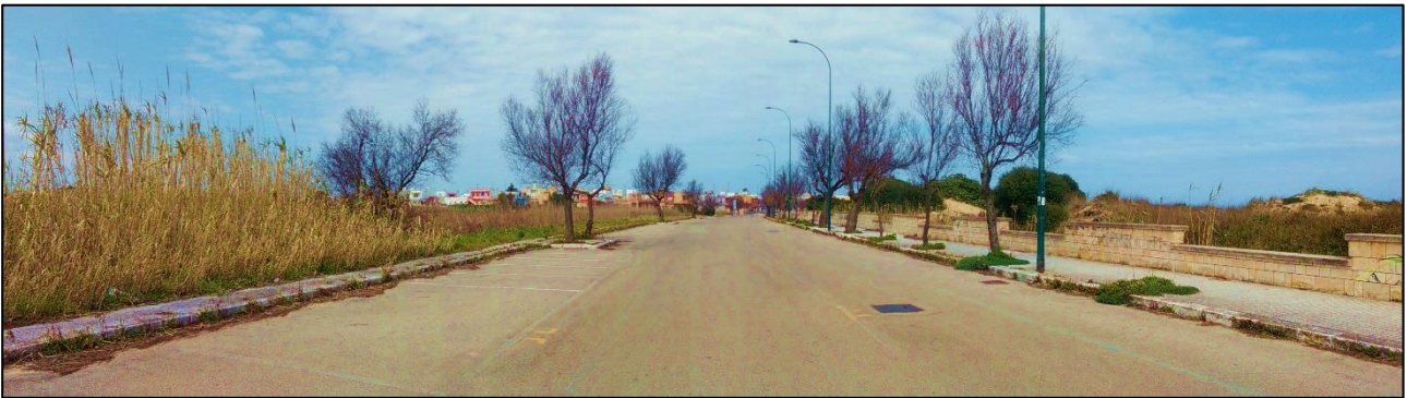
Figura 23 – Viale delle Dune, separa artificialmente la Palude Quatina sulla sinistra e la zona dunale di Torre S. Gennaro sulla destra, costituendo un impedimento al naturale equilibrio tra la zona dunale e retrodunale.
