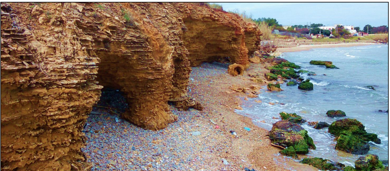
Figura 6 – Falesia con spiaggia ciottolosa al piede in località Lido Presepe.
